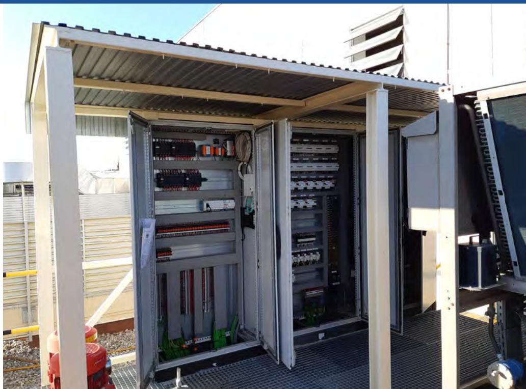
Cuadro de control del sistema de climatización, del Hospital ASEPEYO. Instalación realizada por IMECSA.
